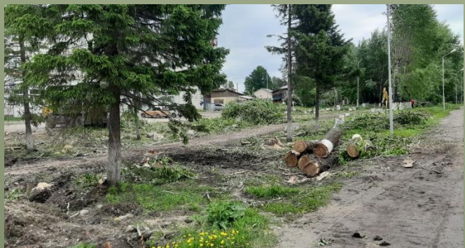
Подготовительные работы: планировка площадей, валка деревьев, корчевка пней
